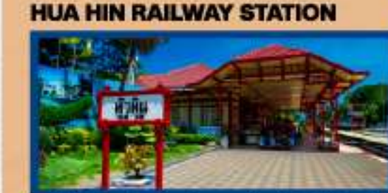
HUA HIN RAILWAY STATION Stasiun kereta tercantik di Thailand, dibangun di tahun 1910.
